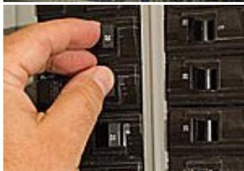
一名維修工走進電氣室要關掉某非製程電路。一時搞錯，他誤關掉了工廠可程式邏輯控制器(PLC)的電源斷路器。他意識到錯了，重置PLC 斷路器並關掉原本要關的斷路器。PLC 短暫電源中斷造成有些製程設備停止而其他設備則繼續運轉。結果是一條製程正嘗試以部分控制來運轉。製程操作被打亂，隔離閥關閉了，而毒性物質排放速率超過排氣洗滌槽的能力。幸好，沒有人受傷，排放物也沒有飛離廠區。
