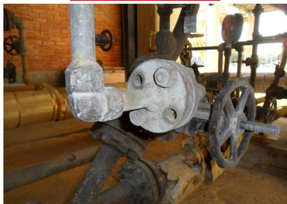
這些照片顯示某工廠在安全檢查時所發現螺栓固定不當的法蘭。在上面的照片中，部分甚或全部的螺栓都太短，螺帽則未完全旋入螺栓。這表示其接合可能沒有它本來應有的強度。法蘭的設計是要使整個螺帽-螺栓組合能夾緊法蘭。如果螺帽僅部分(未完全)旋入螺栓，其連接強度就可能不夠。
