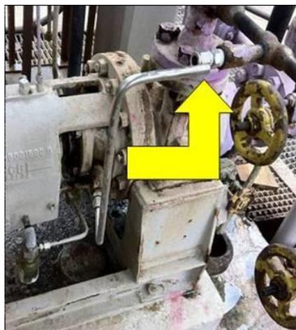
金属製小配管(チュービング)の、適切な設置、メンテナンスおよび点検は、プロセスプラントにおける火災および毒物の放出を防止する上で重要である。それが通常小さいからといって小配管を忘れてはいけない。小さな漏れでも、はるかに大きくなる可能性のある火災を引き起こす場合があり、また、有毒物質は小さな放出でも危険となりうる。
