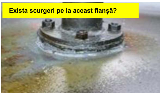
Șuruburi lipsă la prinderea flanșei.
