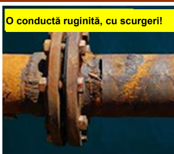
Șuruburi lipsă la prinderea flanșei.
