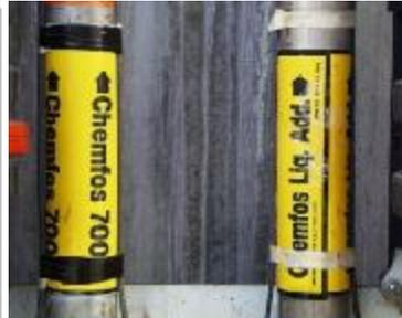
Сходные обозначения на этих трубах привели к разгрузке одного материала в емкость для хранения другого материала. Последовала химическая реакция с выделением токсичного газа, который привел к отравлению 6 человек. Смотри выпуск Beacon за апрель 2012.
