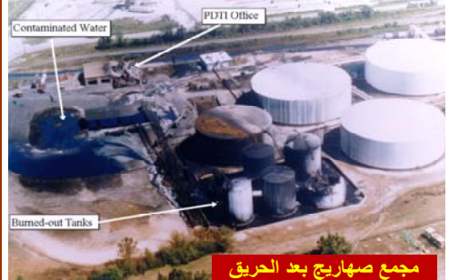
مجمع صهاريج بعد الحريق
