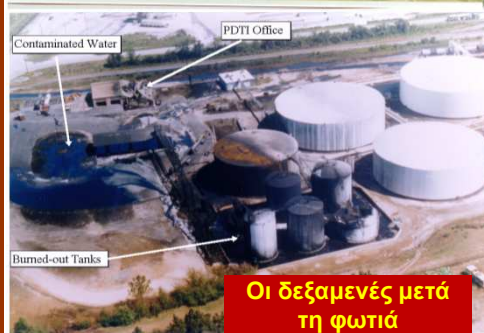
Φωτιά ομάδας δεξαμενών
