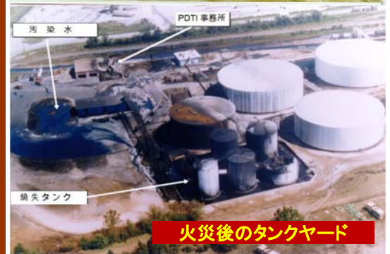
タンクヤード火災
