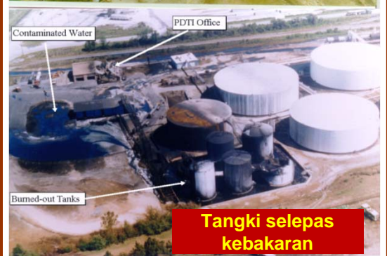
Kebakaran di tangki
