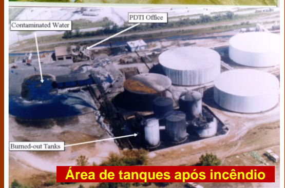
Incêndio em área de tanques
