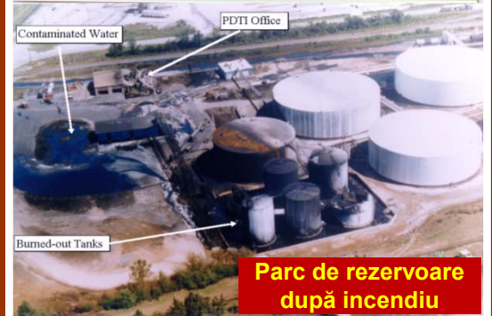
Parc de rezervoare
