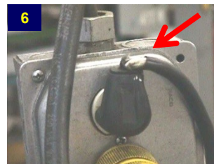
Příklady iniciačních zdrojů: (1) statická elektřina, (2) dopravní prostředek, (3) svařování, (4) otevřený plamen, (5) broušení, (6) poškozené elektrické kabely, (7) pec, (8) pyroforické nebo rozkládající se látky
