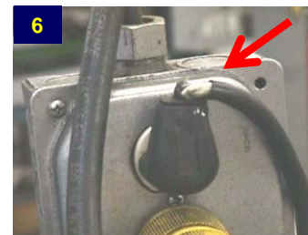
Mogelijke ontstekingsbronnen: (1) statische electriciteit, (2) voertuigen, (3) lassen, (4) open vuur, (5) slijpen, (6) verkeerde elektrische aansluiting, (7) fornuis, (8) pyrofore of ontleedende stof.
