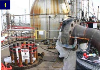
1 Une équipe de maintenance était en train de ré-installer une tuyauterie sur la partie supérieure d'un réacteur au sein d'une raffinerie.
