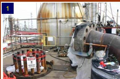
保全作業員が、製油所の反応器の頂部で配管の再設置作業をしていた。反応器は、空気中の酸素が内部の触媒と接触しないように窒素パージされており、反応器の頂部は開いていた(図1)。表示は、反応器が閉鎖空間で、中に入るには許可が必要と表示されていたが、窒素の存在についての警告表示はなかった。作業許可では、「窒素パージまたは不活性化」を示すボックスには「N / A」(該当事項なし)にチェックが入れられていた(図2)。
