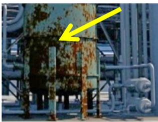
Il serbatoio appare arrugginito e corroso!
