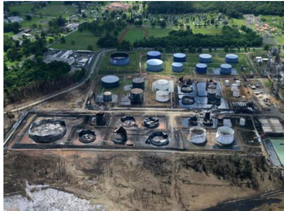
الأضرار التي لحقت بالمنشأة بعد الحريق
