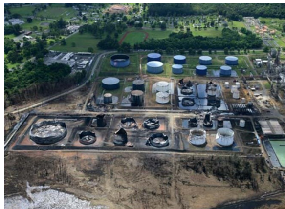
大火过后的设施损坏状况
