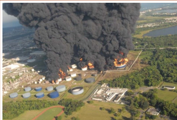
多个贮罐正燃起大火
