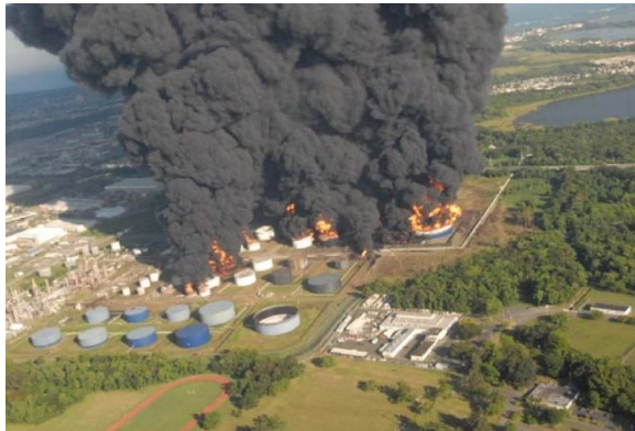
سوختن چندین مخزن در اثر حریق
