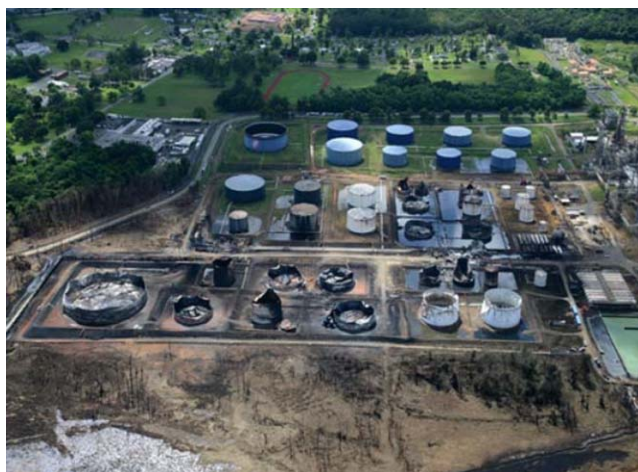
Widok zniszczeń po zakończeniu akcji
