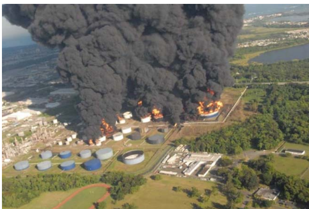
Vários tanques em chamas
