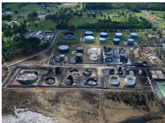
Skadorna på anläggningen efter branden
