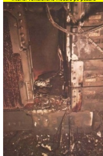
Interiér velitelského modulu po požáru
