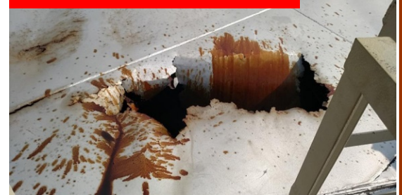
Fig.3: Gat in die dak van die warm olie tenk
