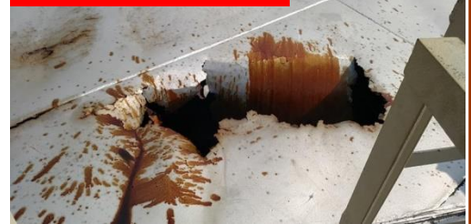
الشكل 3: حفرة في أعلى خزان الزيت الساخن
