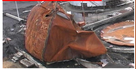
الشكل 2: خزانات الزيت الساخن
