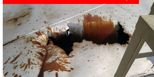
Obr. 3: Díra ve střeše skladovací nádrže horkého oleje
