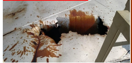
Resim 3: Sıcak yağ tankı tepesinde delik
