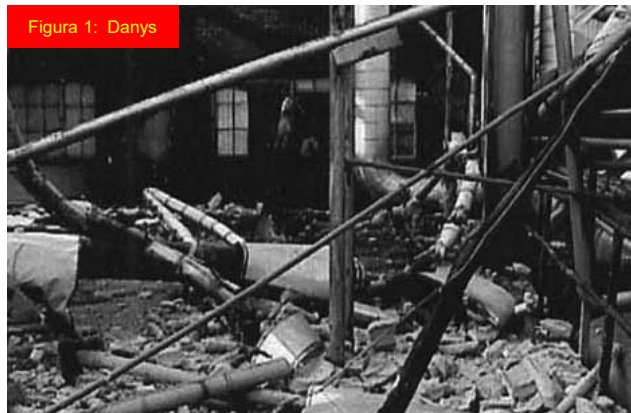
Figura 2: Canonada trencada
