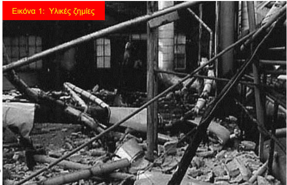
Εικόνα 2: Σπασμένος σωλήνας
