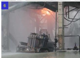
その爆発により、プール火災が発生し、配管、槽類、熱交換器、その他のプロセス機器の支持架構が火災にさらされた。火災発生約30分後に、耐火処理がされていない支柱が倒壊した。その倒壊により、被害が拡大し、可燃物が入った機器・配管からの漏洩が引き起こされた。プラントは避難体制をとり、近隣住民は、シェルターインプレイス(屋内退避)を告げられ、学校も避難をした。火災は5日間続き、製造設備は、5ヶ月間シャットダウンされた。
