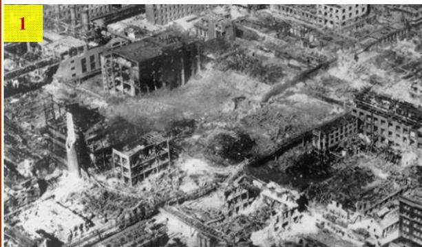
Im Juli 1948 traf ein mit Dimethylether gefüllter Tankwagen in einer Chemieanlage in Ludwigshafen ein. Nachdem er ca. 10 Stunden in der Sonne gestanden hatte hat wahrscheinlich eine Schweißnaht versagt. Es wurde ca. 200 Personen durch die Explosion der entzündlichen Gaswolke getötet. Weitere 4000 Personen wurden verletzt, zum Großteil durch Stofffreisetzungen aus durch die Explosion beschädigten Anlagen (Bild 1).
