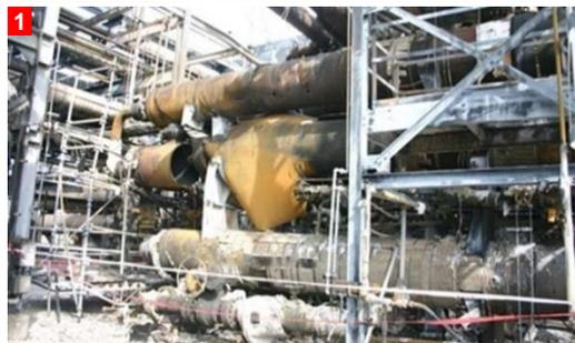
もう一つの事故では、鉍石の処理プラントの屋根が真下の張り出し部の上に崩壊し、プロセス機器に重大な損傷を与えた。幸運にも負傷者は出なかった。屋根の下側の梁が、20年近くもの間、下の機器から出てくるスチームにさらされていた。屋根の上の雪と雨でスチームが凝縮され、梁が腐食した。ある冬、雪の重さでその屋根はついに崩壊した。建物の保守責務者は、そのプラントには誰もいなかった。運転員たちはプロセス機器以外は定期的に点検していなかった。この事故は、機器がプロセスの化学物質に直接触れていなくても、すべての設備とインフラを保守することの重要性を示している。
