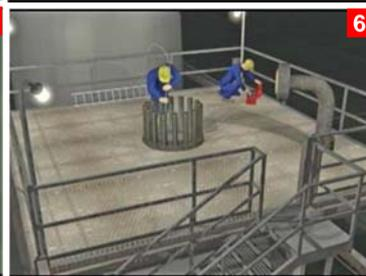
유지보수 하청업체의 작업자가 정유공장내 용기 상부에 있는 배관의 일부를 설치 준비중 이었습니다(1,2). 작업허가서(3)는 밀폐공간의 출입을 요하지 않는 작업으로 발행되었습니다. 작업의 범위는 단지 배관 일부만 설치하는 것이었습니다. 용기는 질소 퍼지중 이었지만, 허가서의 "질소 퍼지 또는 불활성화"란 에는 해당없음으로 기록되어 있었습니다.
