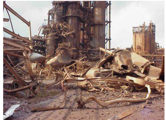
Situation nach der Dampfexplosion
