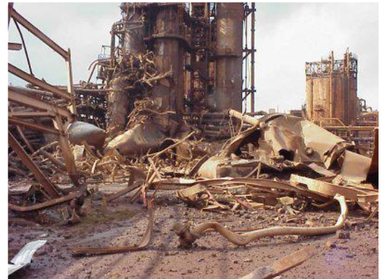
Aftermath of the BLEVE
