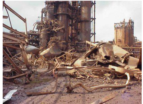
Após o BLEVE
