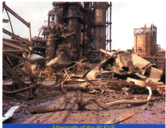
Aftermath of the BLEVE
