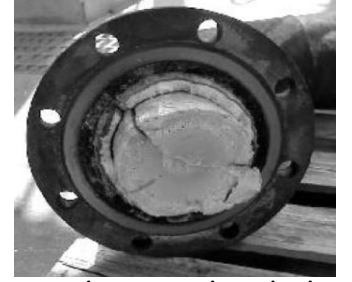
படம் 1: அடைப்பு ஏற்பட்ட வெளிப்போக்கி
