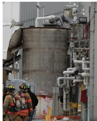
在動火作業時造成致命的火災和超壓之後
