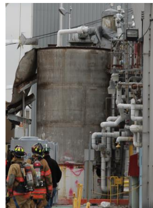
Situación tras un incendio y sobrepresión mortal durante un trabajo en caliente.
