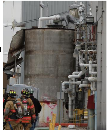
ควันท้องจากเพลิงไหม้และความดันที่สูงเกินระหว่างการทำงานทำให้เกิดประกายไฟทำให้มีคนเสียชีวิต
