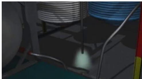
Figura 2. Vapores de processo libertados numa zona baixa perto da área de processo
