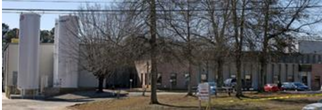
Εικόνα 1. Τοποθεσία των 6 θανάτων από διαρροή αζώτου
