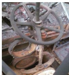
Figure 3. Obturateur de conduite après l'incident
