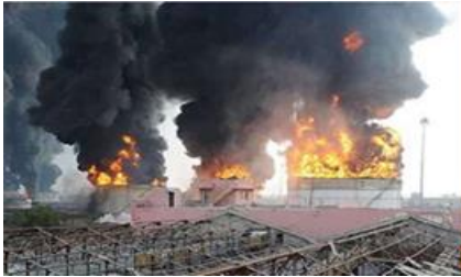
รูปที่ 1 ไฟไหม้ถังเก็บ
