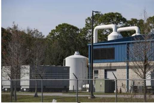
الشكل 1. أولدسمار ، محطة معالجة المياه في فلوريدا
