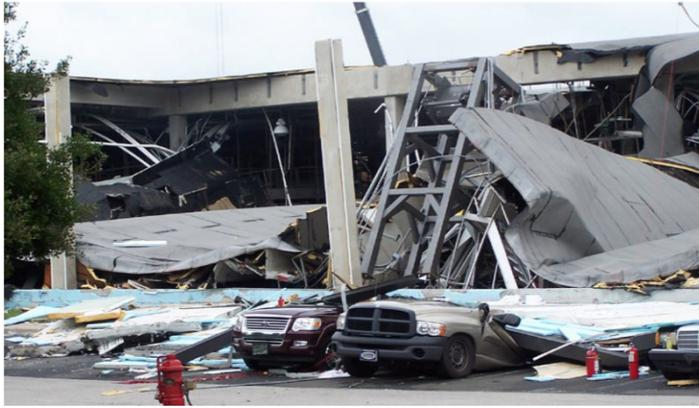
**發生了什麼事？** 2009年6月9日，天然氣爆炸損害了美國北卡羅來納州加納鎮(Garner)的一家肉類加工廠。三名工人死於建築物的一部分倒塌。4名工人被嚴重燒傷，71人被送往醫院。三名消防員接觸到來自工廠冷凍系統的有毒無水氨。大約有18,000磅(8165公斤)的氨外洩，工廠有一大片區域受損。
