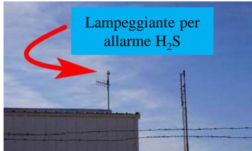
Fig. 2: Lampeggiante allarme H<sub>2</sub>S
