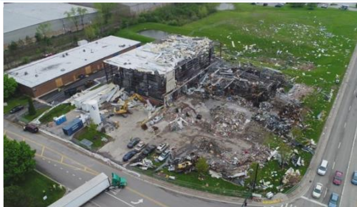
AB Specialty Silicones 社の爆発事故後の設備写真。 (参照: CSB report No. 2019-03-I-IL)
