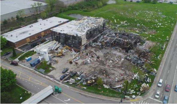
Foto pasca letupan kemudahan AB Specialty Silicones. (Rujukan laporan CSB No. 2019-03-I-IL)
